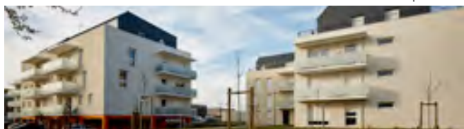
Résidence Les Serpentes
